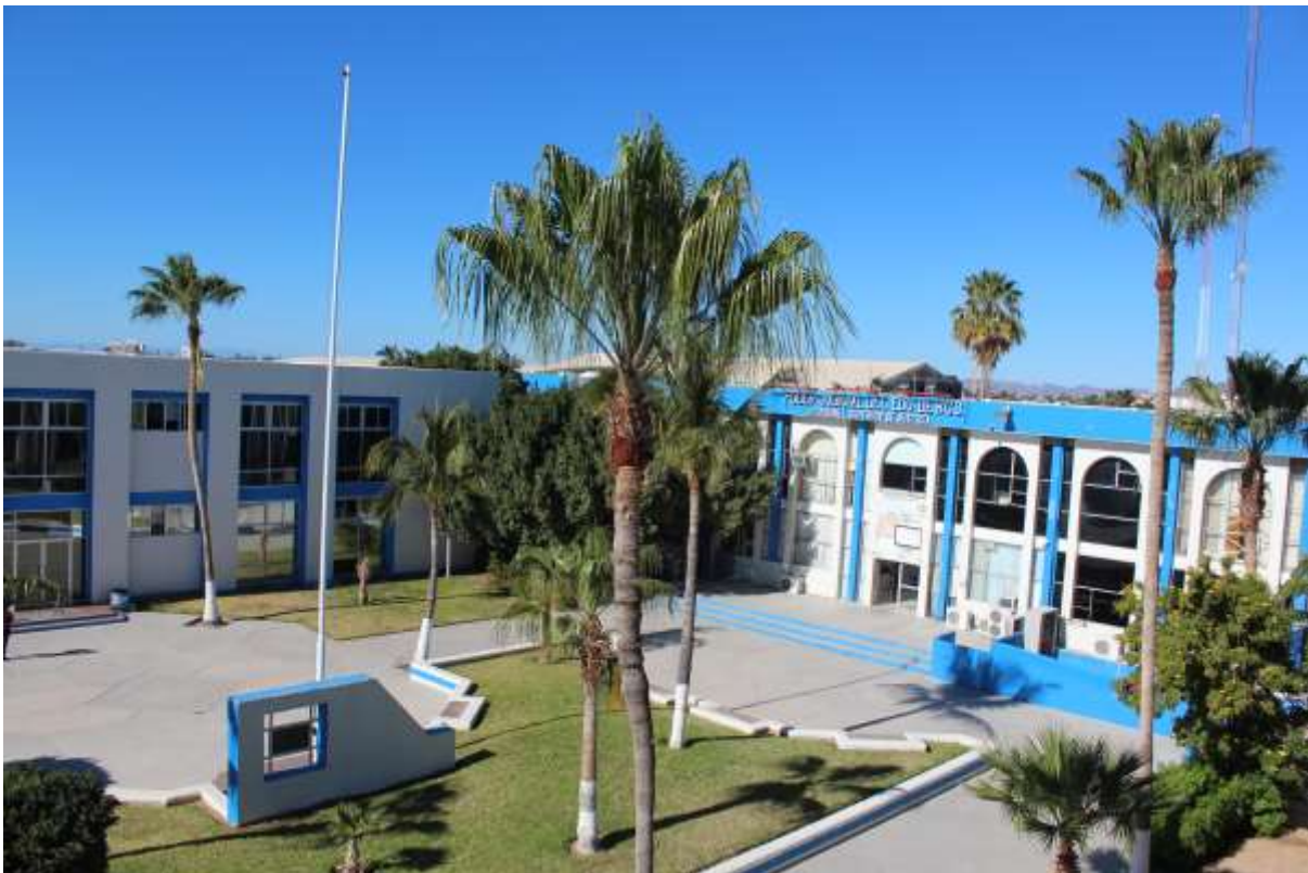
Edificio Principal del Poder Judicial del Estado de Baja California Sur, Plaza de la Justicia, ciudad de La Paz, BCS
