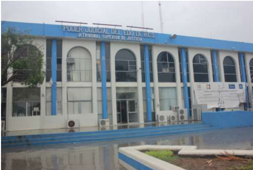
Edificio Principal del Poder Judicial del Estado de Baja California Sur.
