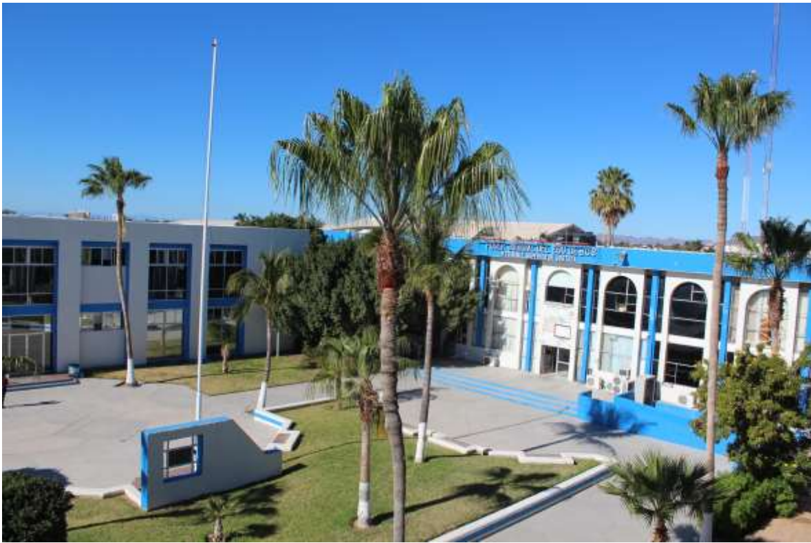
Edificio Principal del H. Tribunal Superior de Justicia del Estado de Baja California Sur.
