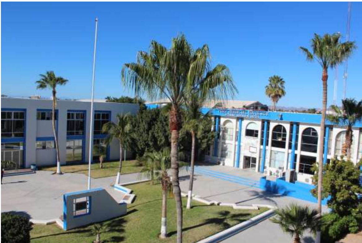
Edificio Principal del H. Tribunal Superior de Justicia del Estado de BCS
